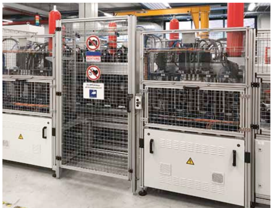
Backpaketieranlage der SWD AG: Backen bei Temperaturen von bis zu 230 Grad Celsius – statt Schweiessen.
