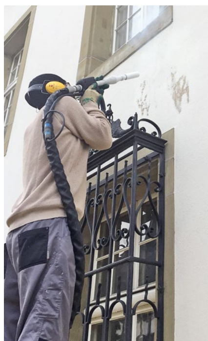
Im Einsatz: Mit Trockeneis Graffiti entfernen.
