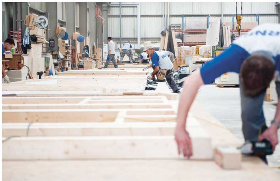
Eingespieltes Team von Spezialisten: Zusammenbau der Holzrahmen für die Elemente.
