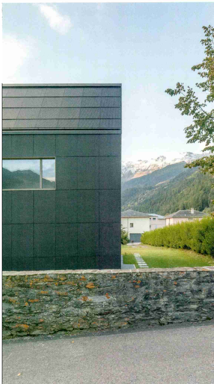
Für die Stromproduktion muss die PV-Anlage auf der Nordseite optimal ausgerichtet sein.
