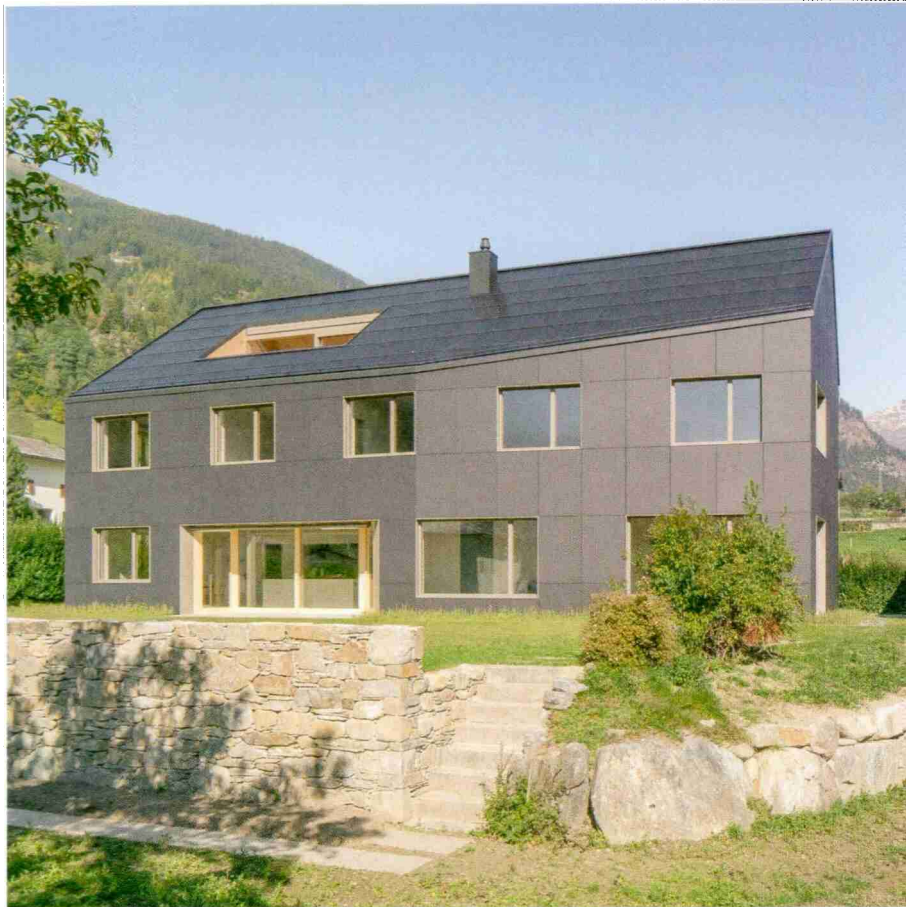
Fassade und Dach des Mehrfamilienhauses sind vollständig mit einer PV-Anlage ausgestattet.
